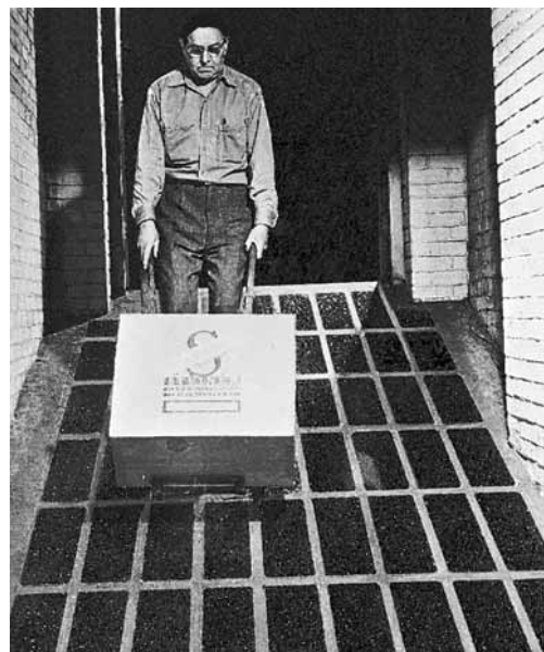
Fig. 1: rampe avec un revêtement antidérapant.
