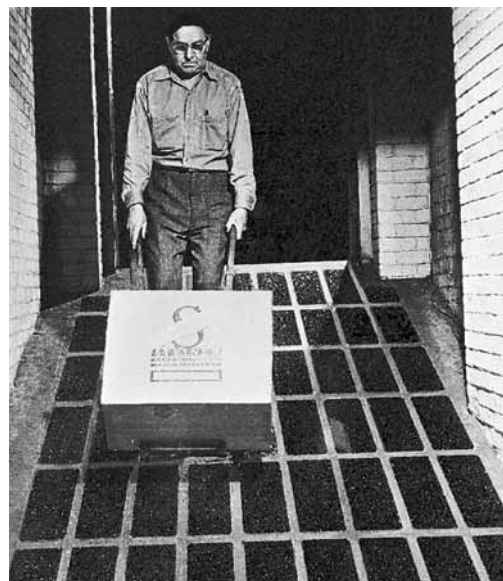
Bild 1: Rampenauffahrt mit rutschfestem Belag.
